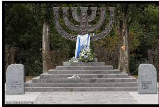
El Memorial del Holocausto en Kiev, dañado por los bombardeos rusos.
